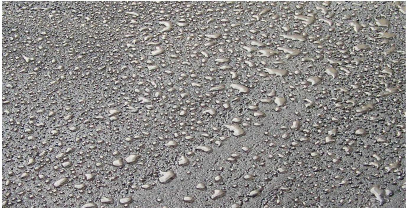
Рисунок 7 – Стабилизация гидроизоляционной мембранны после напыления
