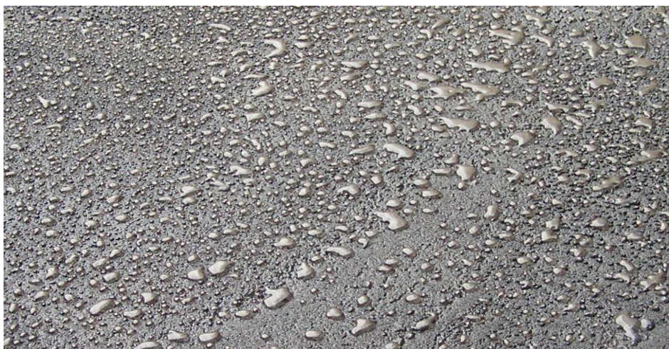
Рисунок 3 – Стабилизация гидроизоляционной мембраны после напыления
