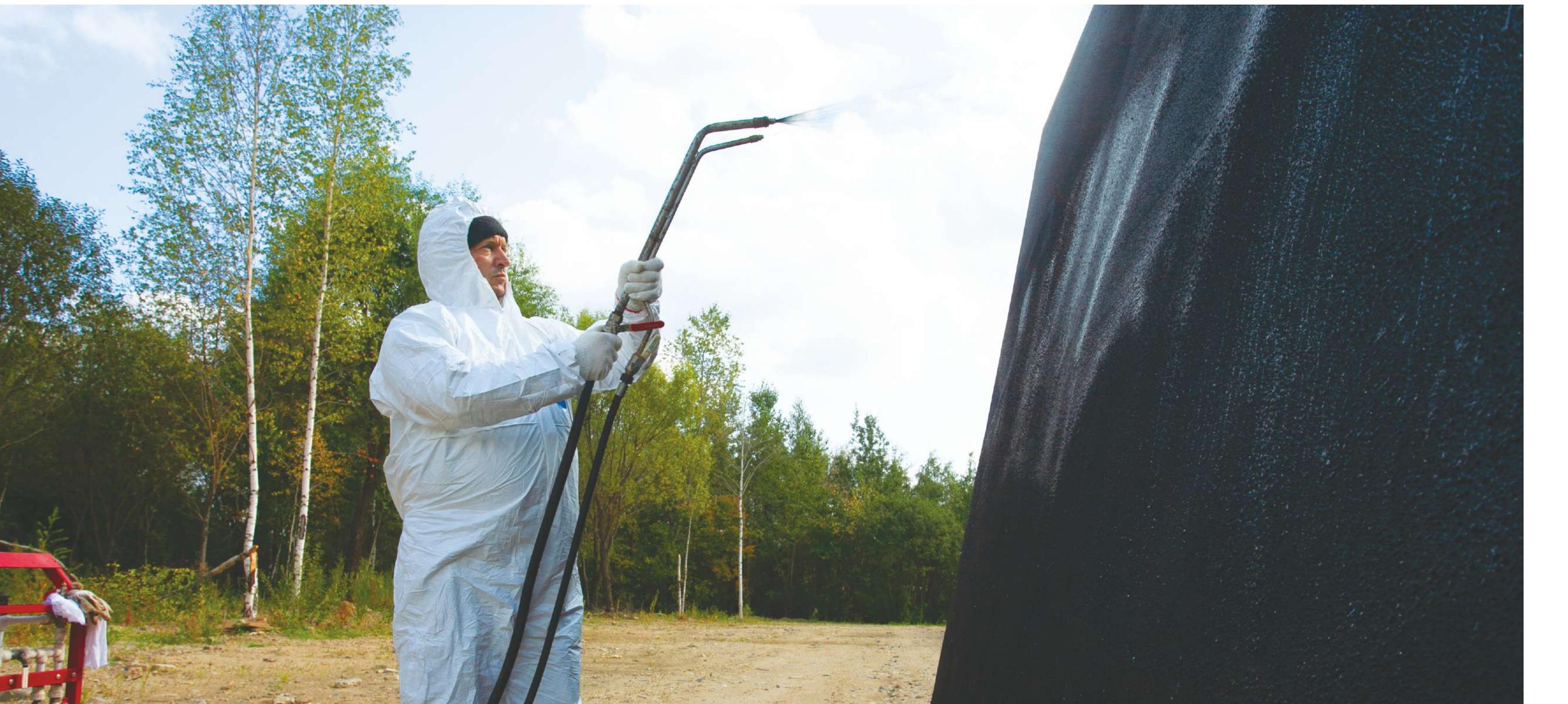
Мембрана наносится одновременным распылением двух компонентов отдельными пересекающимися факелами\*. Частицы битумно-латексной эмульсии (компонент А) смешиваются в воздухе с коагулянтом (компонент В), запуская процесс реэмульгации. Эмульсия разделяется на твердую и жидкую фазы: битум с латексом затвердевают, вода вытесняется. Гидроизоляционный слой устраивается за один проход на требуемую толщину от 3 до 6 мм, температура нанесения от +5 °C до +35 °C
